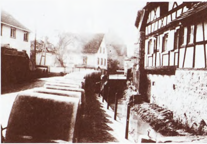
Durch den zunehmenden Verkehr mußte der Au Graben vom ehemaligen alten Rathaus bis zur Dorfmühle verdohlt werden. Die Bilder zeigen die Erdarbeiten in der Lahrer Straße.
