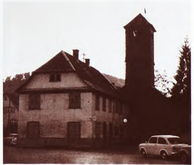
Das alte Rathaus. Im Erdgeschoß war die Milchsammelstelle eingerichtet.
