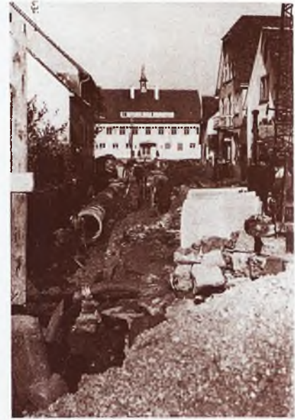
Durch den zunehmenden Verkehr mußte der Au Graben vom ehemaligen alten Rathaus bis zur Dorfmühle verdohlt werden. Die Bilder zeigen die Erdarbeiten in der Lahrer Straße.
