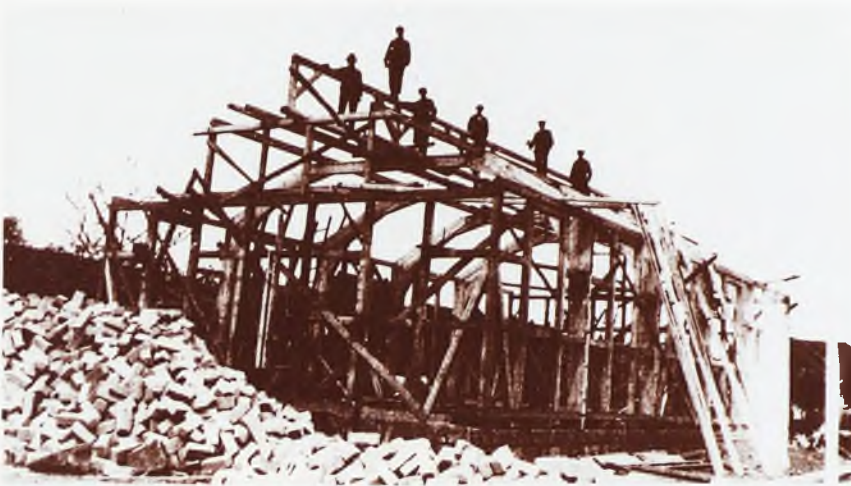
Die Holzkonstruktion der Turnhalle beim Richtfest 1936
